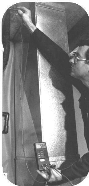
Si la montée de température mesurée dépasse les valeurs indiquées, le flux d'air est trop faible. Vous devez faire passer plus d'air par l'échangeur thermique en éliminant les obstructions dans le système d'air ou en augmentant le débit. Si la montée de température mesurée est inférieure aux valeurs indiquées, le flux d'air est trop fort. Utilisez une prise d'air moins rapide sur le souffleur à plusieurs vitesses.
